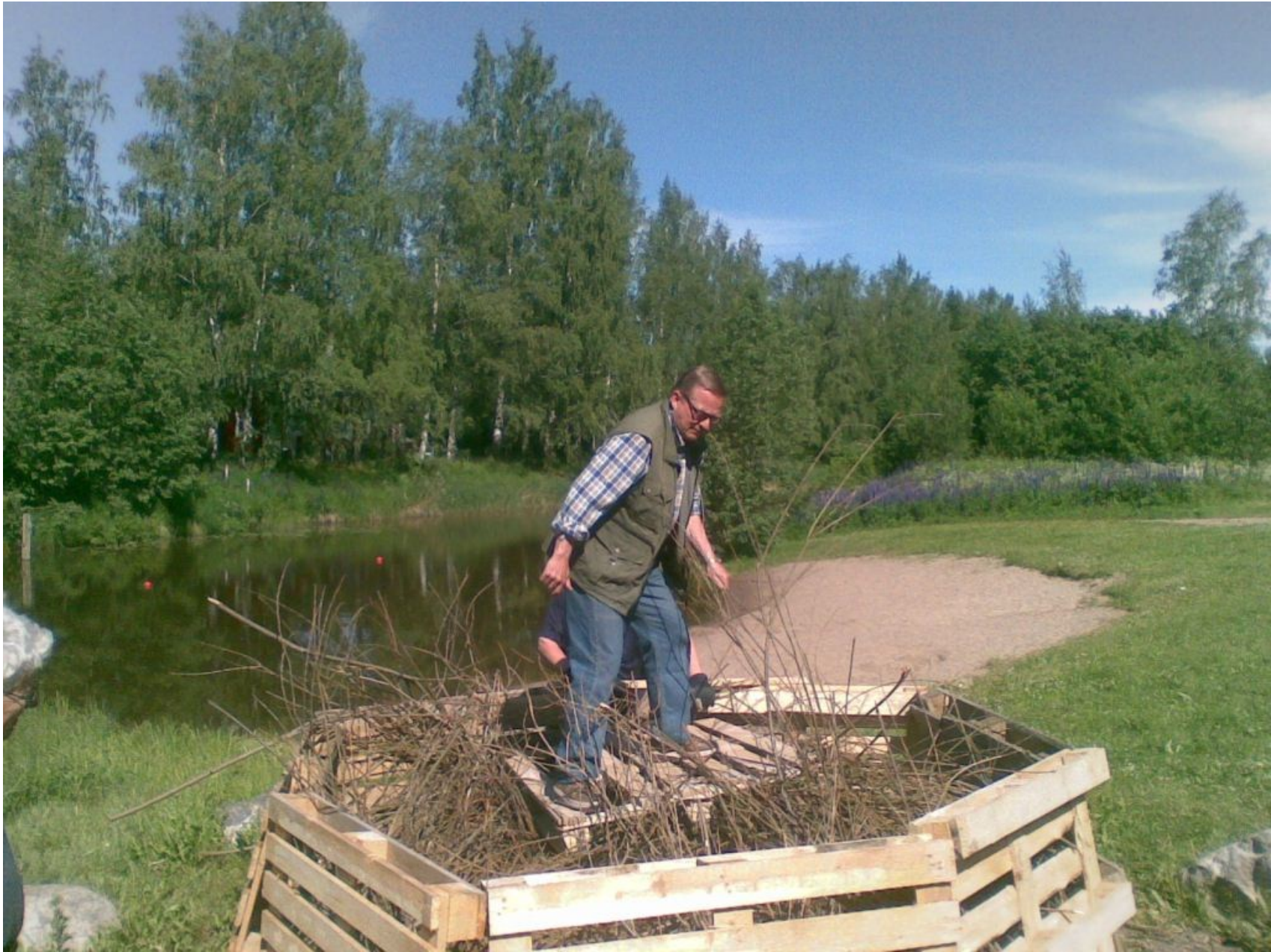
Kokon pohjaa rakennetaan
